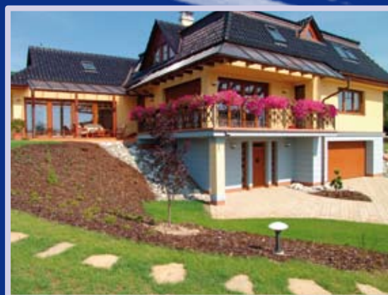
Stavba rodinného domu Zlín
