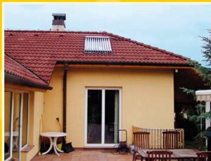
Rodinný dům – realizace solárních kolektorů
