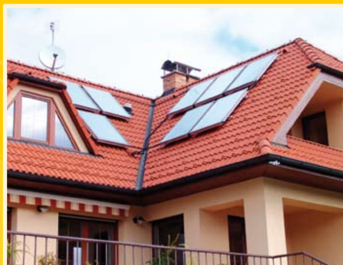
Rodinný dům – realizace solárních kolektorů
