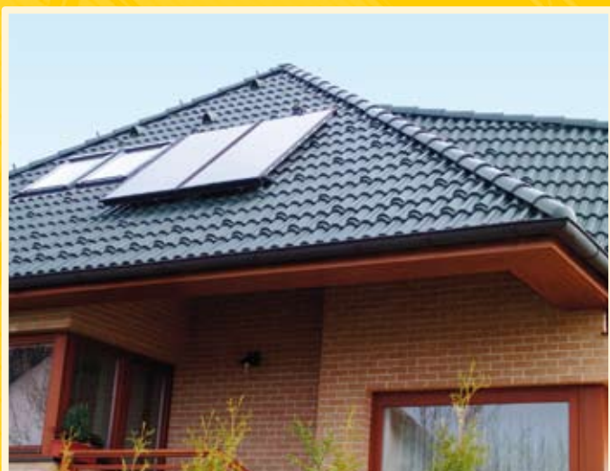
Rodinný dům – realizace solárních kolektorů
