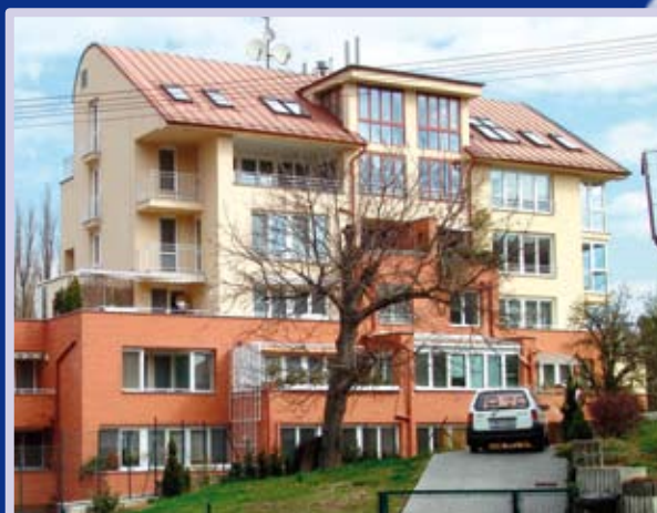
Bytový dům Zlín – obkladačské práce
