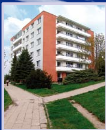
Bytový dům Zlín – revitalizace panelového domu (zateplení, výměna oken, rekonstrukce
