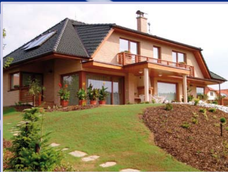
Stavba rodinného domu Zlín
