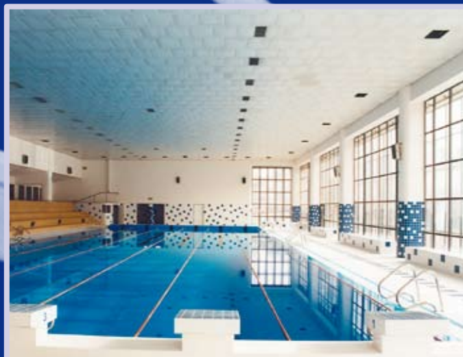
Městské lázně Zlín – rekonstrukce 25 m bazénu
