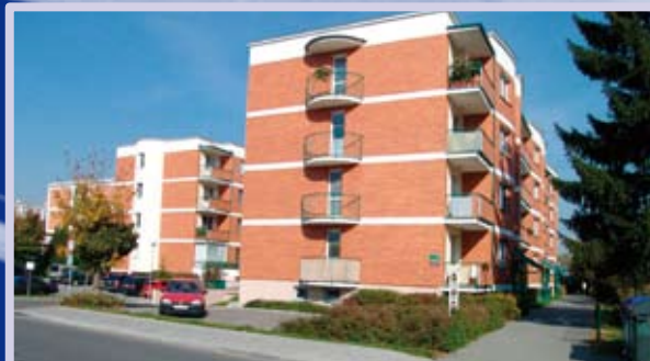
Bytový dům Zlín – obkladačské práce
