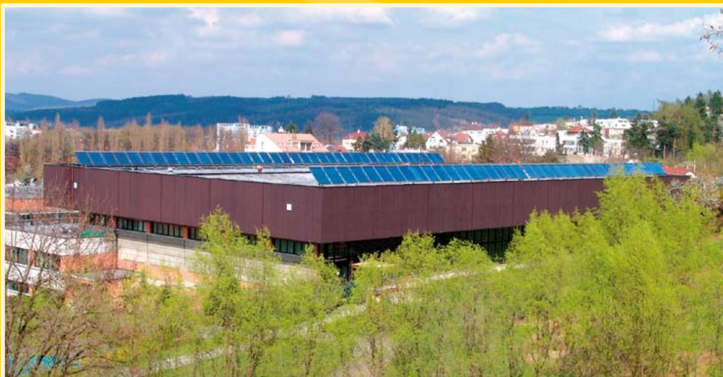
Městské lázně Zlín – realizace solárních kolektorů
