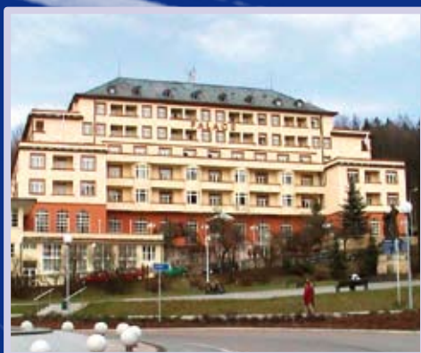
Lázeňský dům Palace Luhačovice – obkladačské práce
