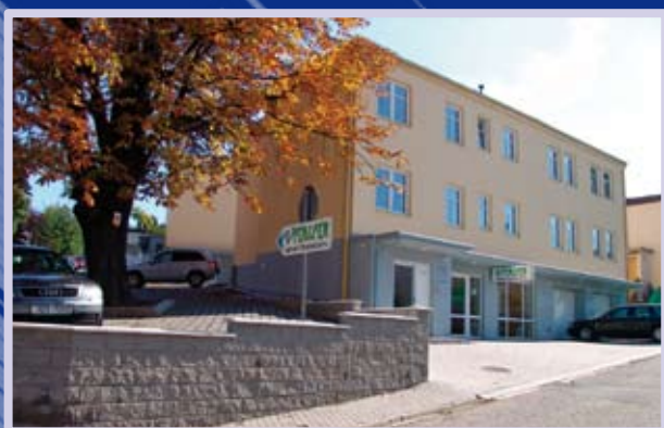
Realizace bytového domu Zlín
