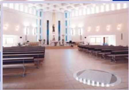
Kostel Panny Marie Zlín – obkladačské práce
