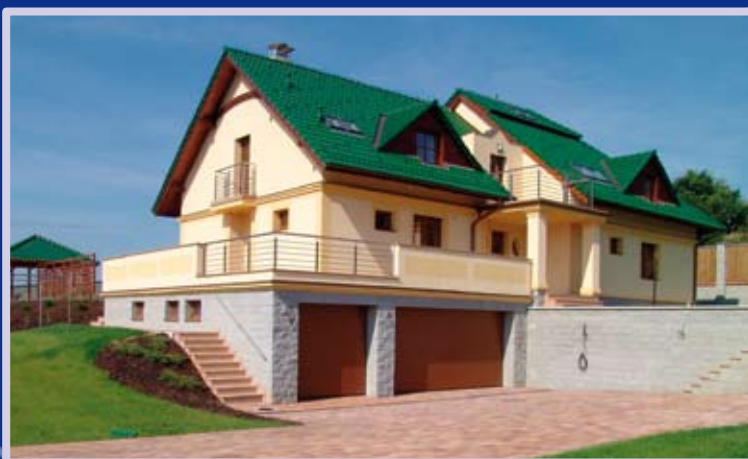
Stavba rodinného domu Zlín
