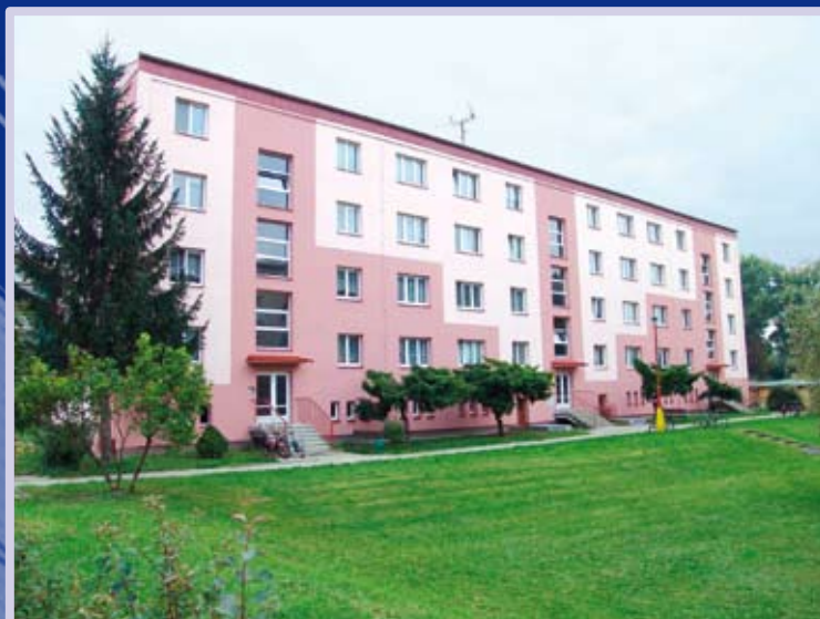
Revitalizace bytového domu Uherské Hradiště
