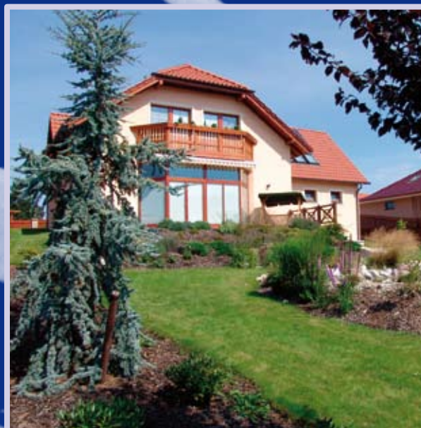
Stavba rodinného domu Zlín
