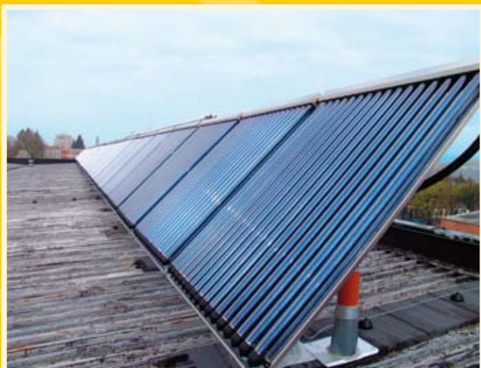
Městské lázně Zlín – realizace solárních kolektorů
