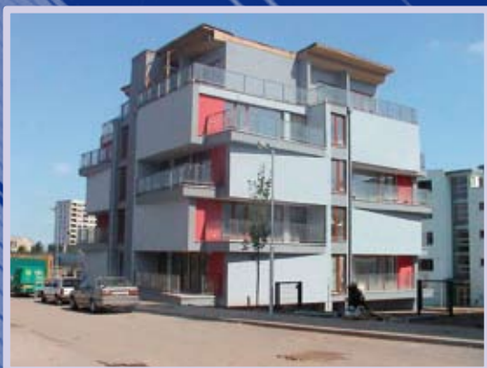
Bytový dům Praha – obkladačské práce
