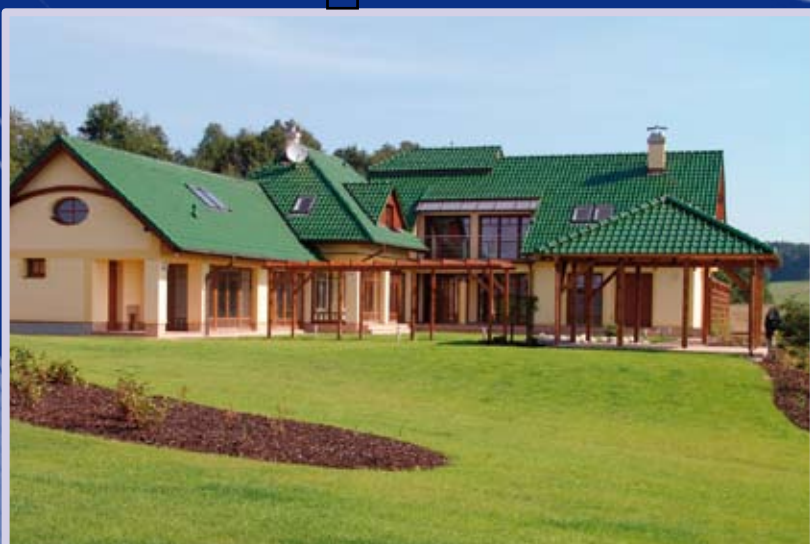
Stavba rodinného domu Zlín
